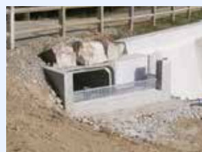
L'évacuateur de crue a été refait. Une buse cadre a été installée pour le franchissement de la route. Un évacuateur d'eau de fond a été installé.
