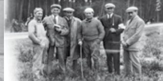
Pilotes sur le circuit de la Sarthe - 1920 (3 e en partant de la gauche)
