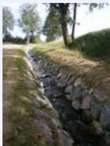
2 Une dérivation du Perche l'Oiseau a été tracée : l'étang n'est ainsi plus un obstacle à la continuité écologique.
