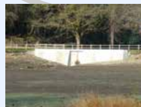
Le parement amont de la digue était en mauvais état : il a été renforcé par un paroi en béton au niveau de la vanne de vidange.
