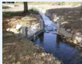
Le répartiteur permet de gérer les écoulements entre l'étang et la dérivation.
